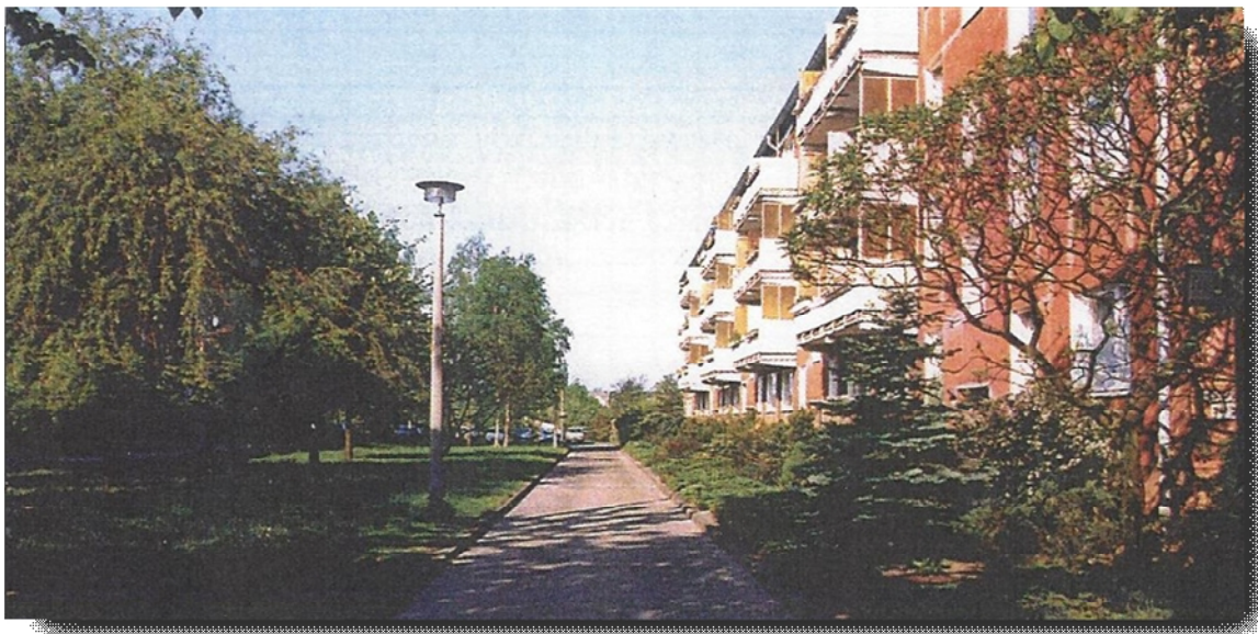
Bild 3: Wohngebiet in Köpenick Nord Erschließungsstraße, Q3A Blöcke
