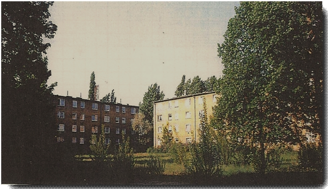
Bild 5: Q3A-Ensemble im derzeitigen Zustand mit Flachdachkonstruktion
